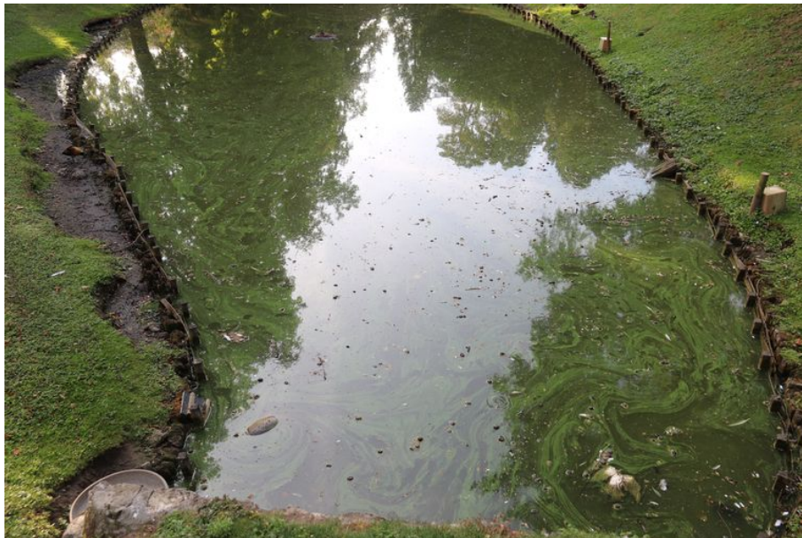
© RV De oeverplanken zijn op heel wat plaatsen weggerot.
